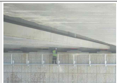
▲ 교량받침 점검로 근접조사
