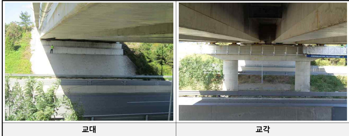
[교대 및 교각 전경]
