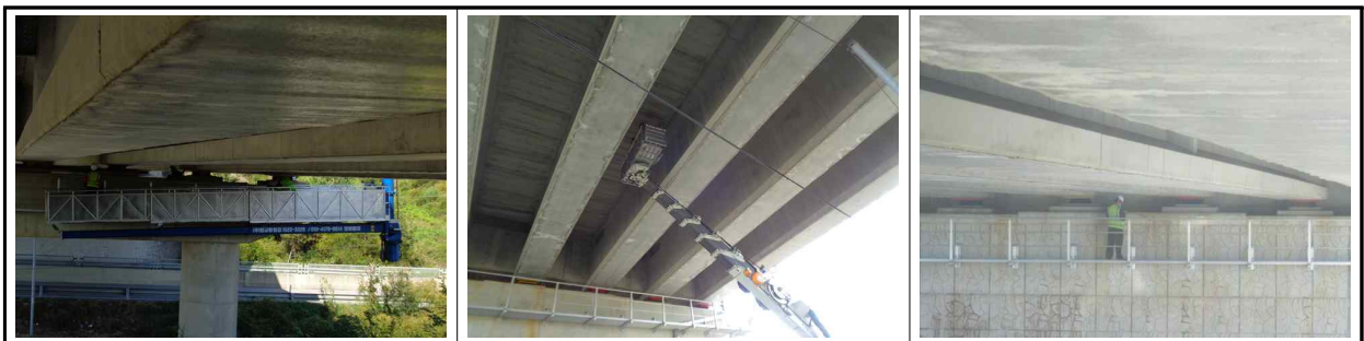
[고소작업차, 굴절점검차를 이용한 근접조사 실시]
